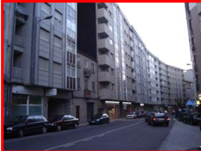
A Avenida de Portugal deixará de estar colapsada de tráfico
